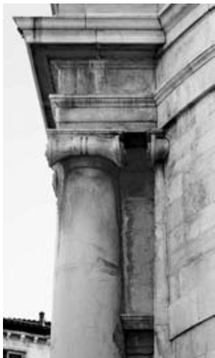
FIG. 20. T. TEMANZA, Chiesa della Maddalena , Venezia, particolare con l'innesto della facciata nel corpo di fabbrica.
