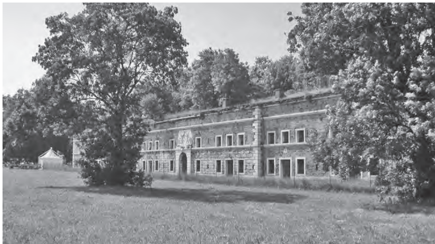
FIG. 2. Forte Marghera, una delle due caserme a prova di bomba.
