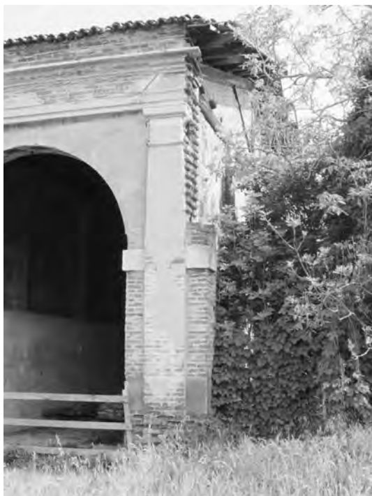
FIG. 5. Barchesse della Cucca, particolare dell'ultima arcata con ammorsature.
