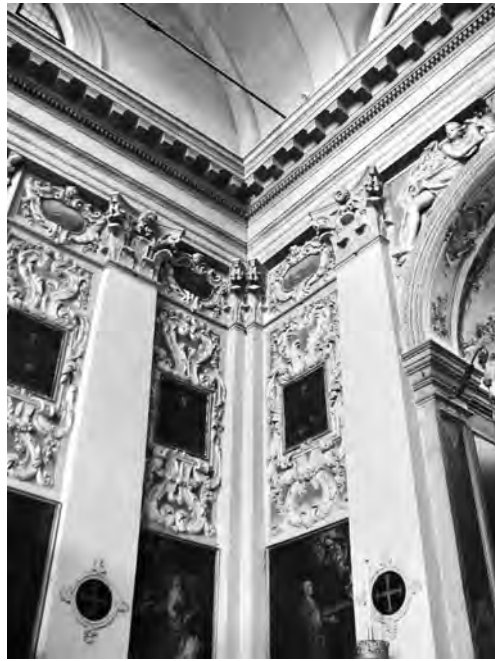
FIG. 5. Paraste e apparati decorativi, controfacciata e Cappella da Ponte.
