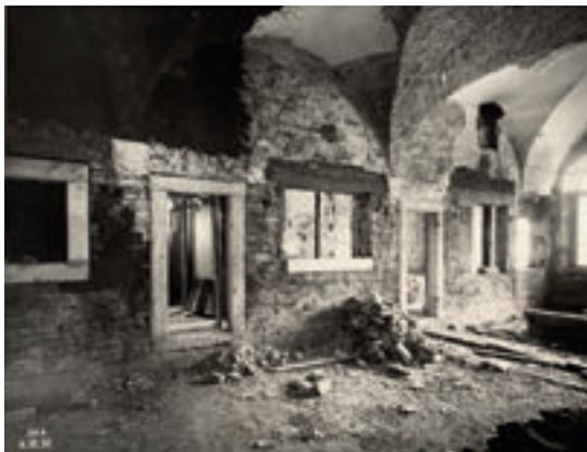
La Sala Messina nel dicembre 1952 durante i lavori di restauro. Si nota l'apertura delle finestre con l'inserimento delle mostre in pietra d'Istria e la catramatura delle pareti fino all'altezza delle volte
