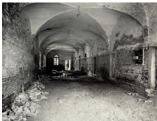
La Sala Messina nel 1952 durante i lavori di restauro. Si notano le porte dotate di sopra luce, l'assenza delle finestre, l'apertura centrale sul lato corto ancora aperta, l'abbassamento della quota pavimentale e la presenza di una porta che immetteva sul chiostro oggi non più visibile.
